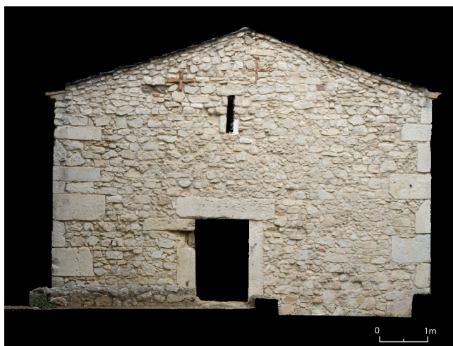
Orthophotographie de la façade ouest de la chapelle. Cette vue est réalisée par mappage de la photographie sur une surface triangulée à partir du nuage de points 3D.
